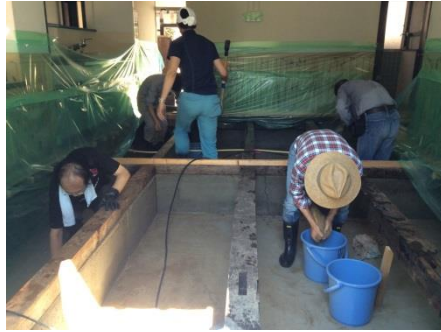
部屋内を養生して撤去作業
