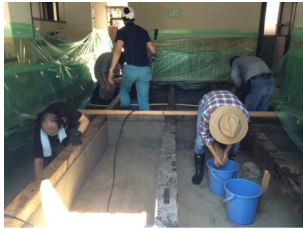
部屋内を養生して撤去作業
