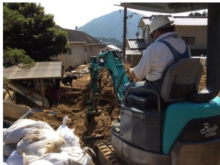
重機による土砂撤去
