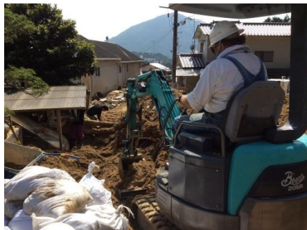
重機による土砂撤去
