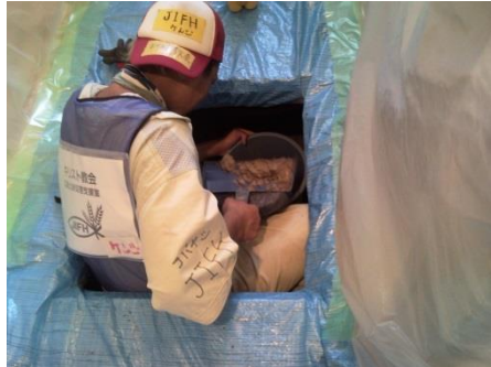
床下からの泥撤去
