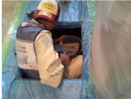
床下からの泥撤去
