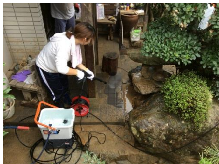
高圧洗浄機による清掃
