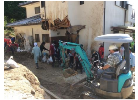
重機による土砂出し
