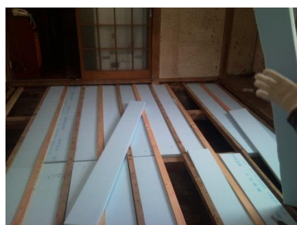
床下、断熱を入れコンパネを貼ります
