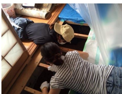
いまだ続く床下の泥出し
